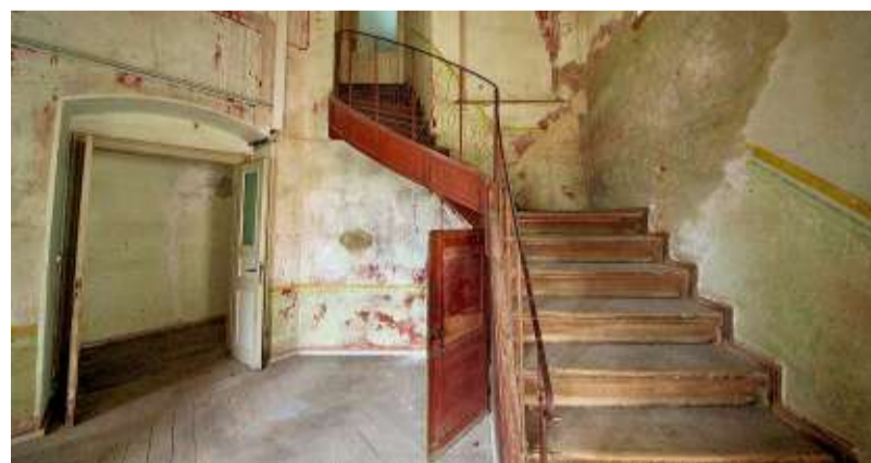
Treppenaufgang im Schloss Droyßig
